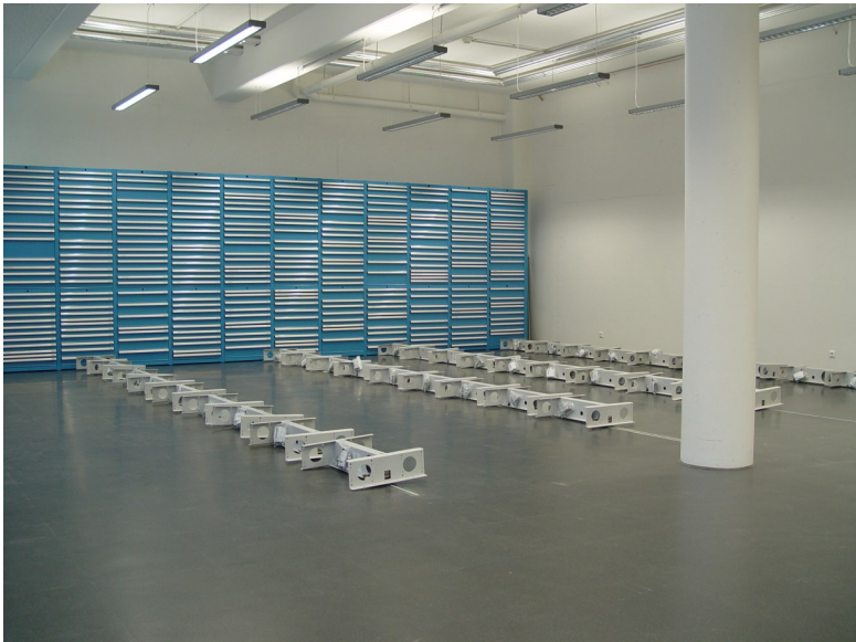
2005 - Aufbau des Kompaktus (Schieberegalanlage). Foto: Geosammlung.
