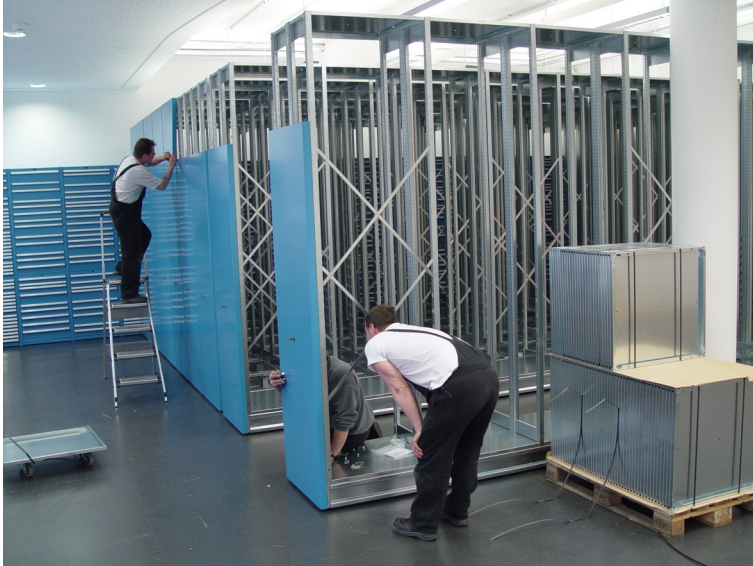
2005 - Aufbau des Kompaktus (Schieberegalanlage). Foto: Geosammlung.
